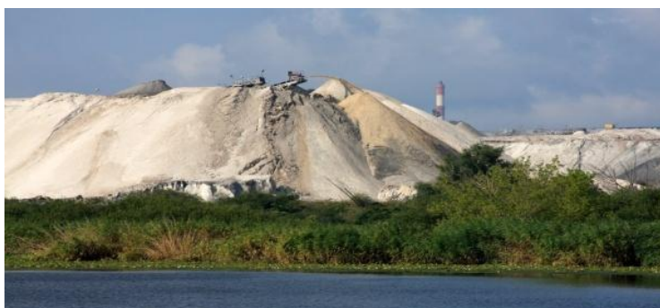
Rys. 13. Hałdy odpadowego fosfogipsu w Policach.
